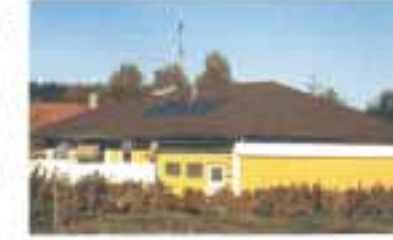
(Sistema solar doméstico para generación de agua caliente, Austria.)
